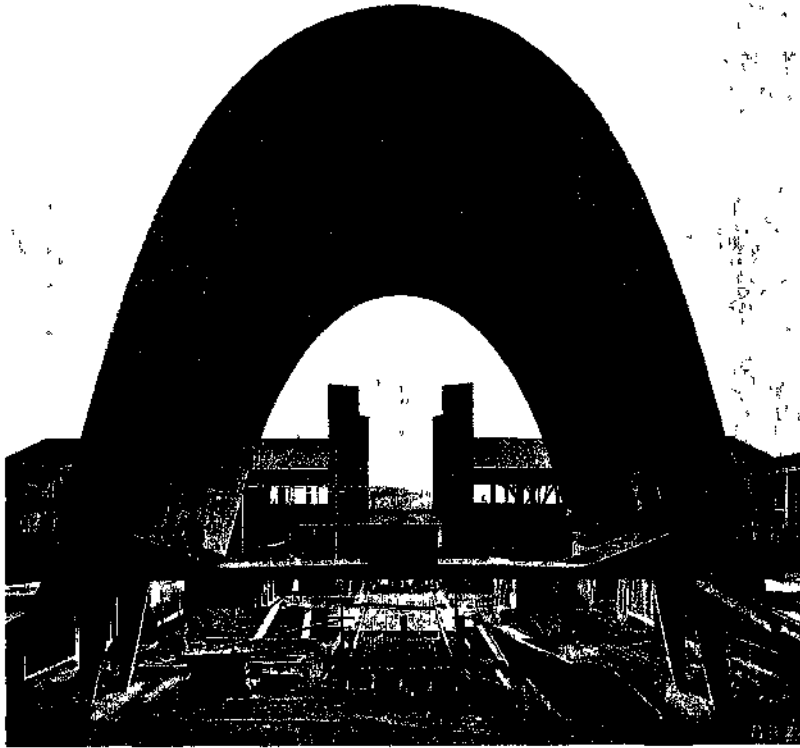
Abb. 44 In der Abteilung «Bauen» [37]. Arch. H. LEUZINGER, Ing. R. MAILLART
