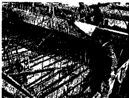
Abb. 48 Strebenfuss-Fundament mit der Verankerung der Holzpfahle
